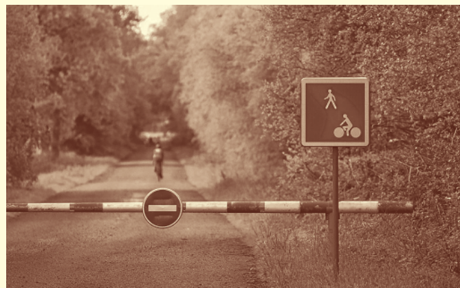
Barrière d'accès rabattable pour restreindre les accès, Lamballe-Armor
